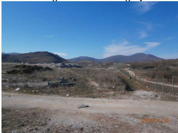
Slika 5: Odlagalište komunalnog otpada Stražbenica
